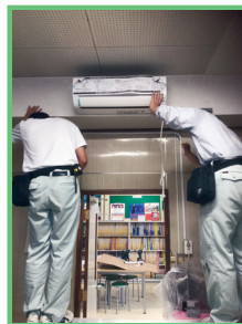
エアコン取付実習
