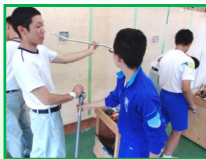
【金属管工事コース】
